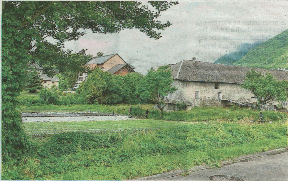
En revivant, la ferme Chautemps va offrir du travail aux personnes accueillies par l'association Terre solidaire. Photo Le DL/J-P.S.
