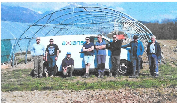
Les salariés d'Axians ont prêté main-forte aux membres de Terre Solidaire pour le montage des deux nouvelles serres. Photo Laurent Pachod
